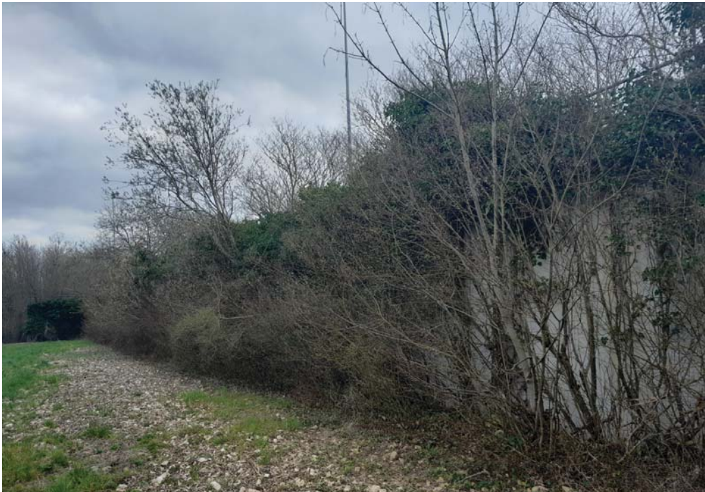
Mur d'enceinte le long du périmètre empêchant tout ruissellement
